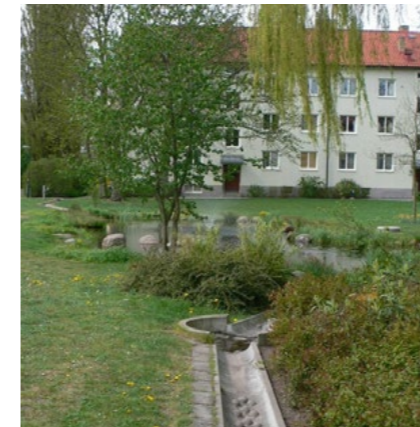
Augustenburgo rajone suprojektuoti latakai padeda vandeniui judėti tarp tvėnkinių, o cirkuliaciniai siurbliai, nedideli vandens kriokliai ir fontanai padeda išvengti per didelio dumblių augimo, nuotr. Va SYD (n.d.).
