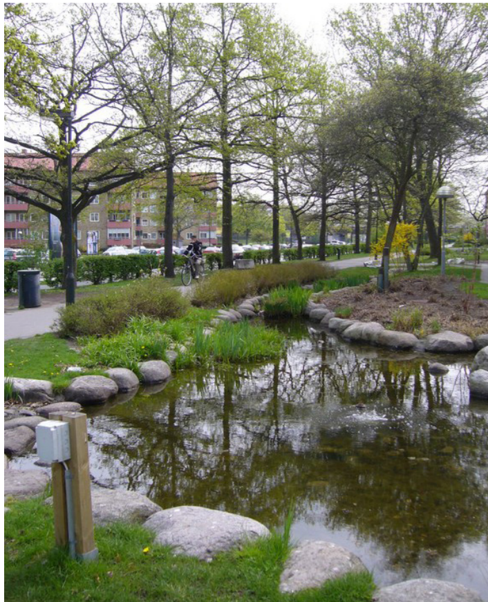
Augustenburho rajone suplanuoti drenažo kanalai su augalijos filtrais, kurie užtikrina natūralų vandens valymą sekiose kanalų ir tvenkinių dalyse, nuotr. Town and Country Planning Association (n.d.).
