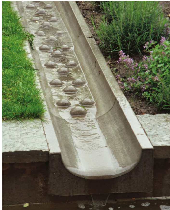
Augustenburho rajone suprojektuoti latakai padeda vandeniui judėti tvenkiniuose, o cirkuliaciniai siurbiai, nedideli vandens kriokliai ir fontanai padeda išvengti per didelio dumblių augimo, nuotr. Va SYD (n.d.).
