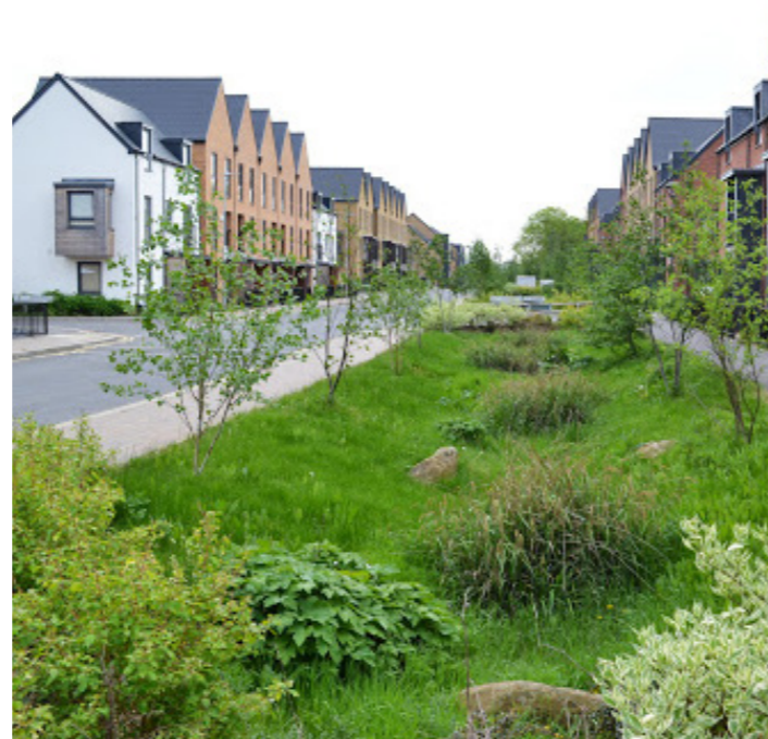
Tvarūs paviršinio vandens surinkimo sprendimai integruoti į RAF Uxbridge teritorijos detalų dizainą vakarų Londone, nuotr. Allen Pyke Associates (2018).
